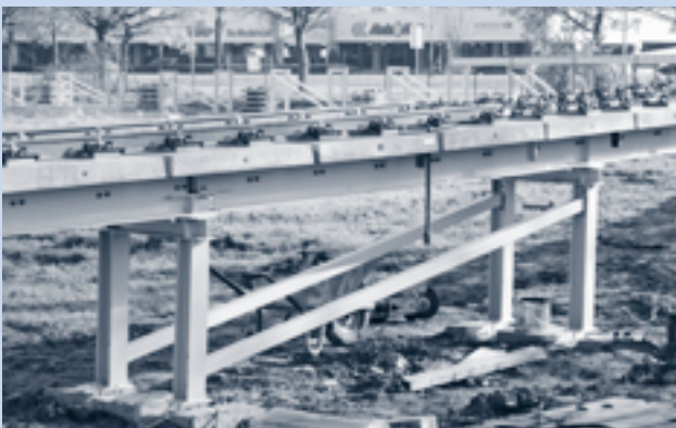
Stahlkonstruktion der NBP-Versuchsstrecke
